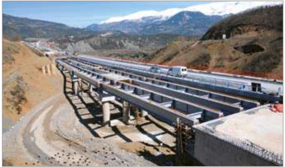
Γέφυρα T8, Εγνατία οδός (ΑΕΓΕΚ κατασκευαστική Α.Ε.)
