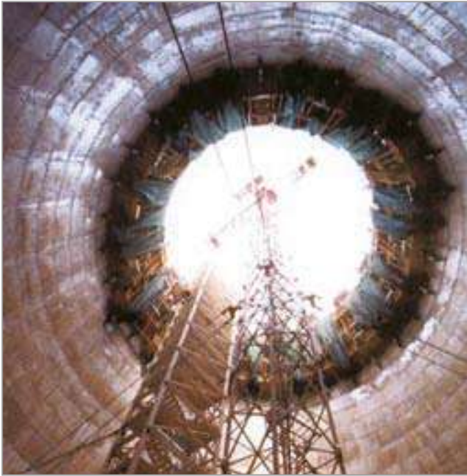
Κλιμακοστάσιο στο εσωτερικό πυλώνα (Κ/Ξ Γέφυρα)
