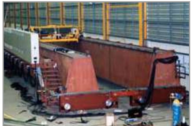
Κατασκευή box γερανογέφυρας
