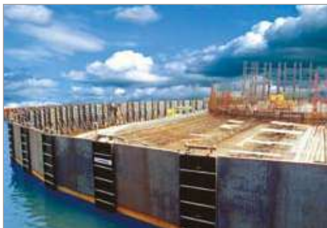
Φράγμα κατασκευής πυλώνων (Κ/Ξ Γέφυρα)
