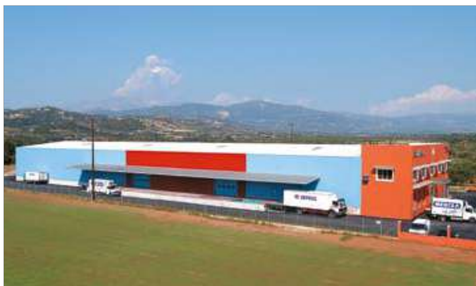
Κέντρο αποθήκευσης & διανομής προϊόντων (Ζερβας Α.Ε.)
